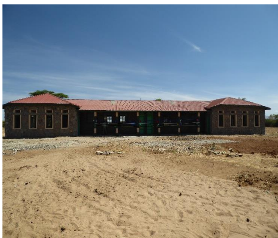
Schulgebäude mit 4 Klassenräumen
